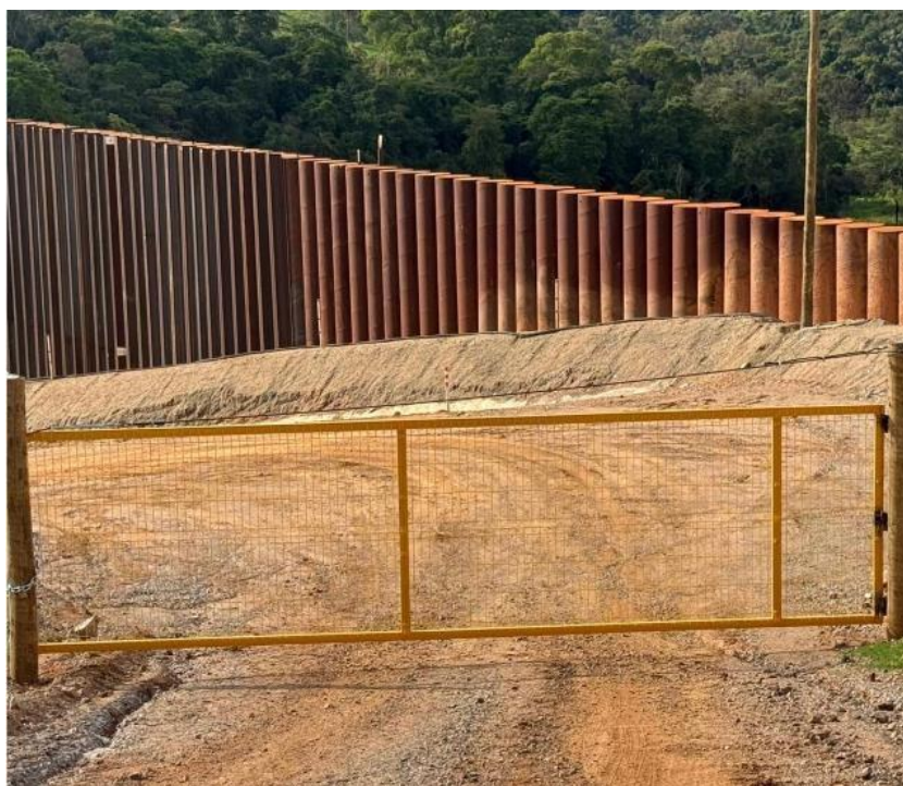
Portão instalado para restrição de acesso
