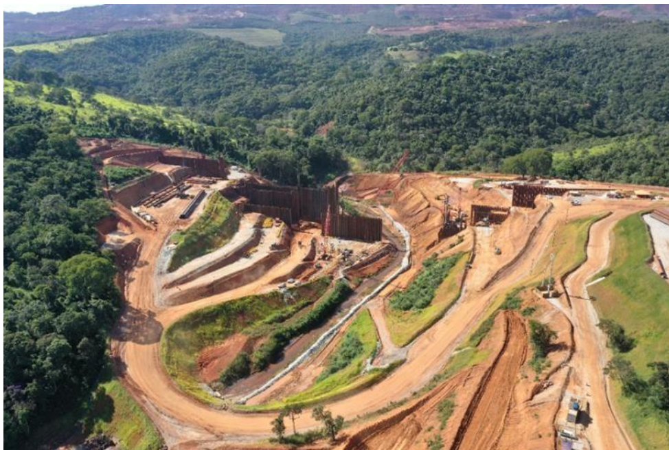
Vista a partir da área a jusante da ECJ em março de 2023
