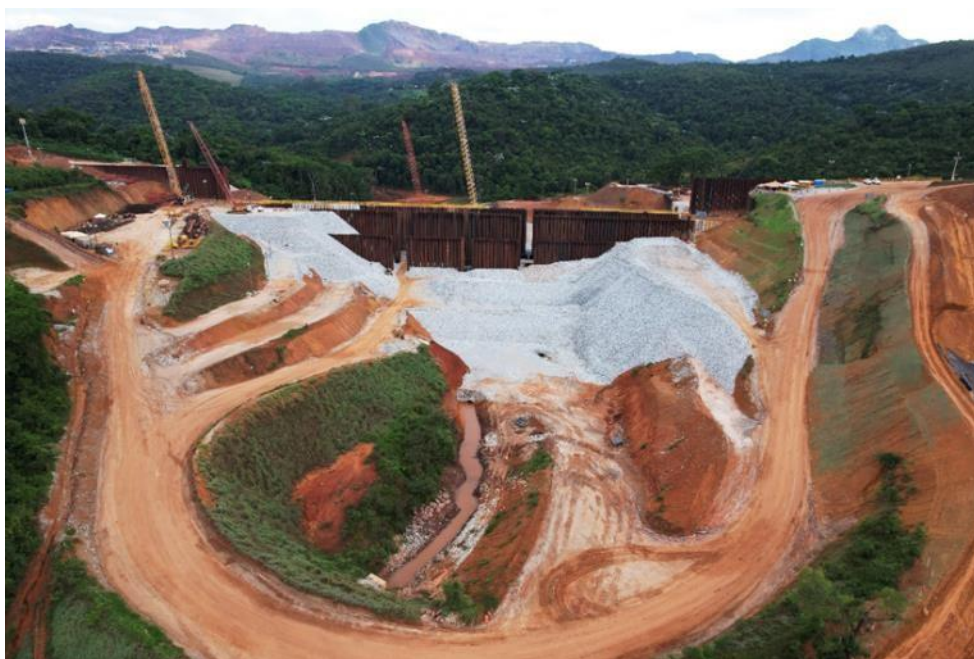
Vista a partir da área a jusante da ECJ em novembro de 2024
