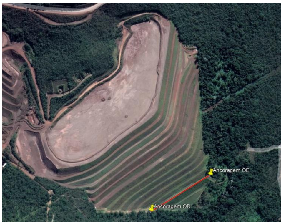
Figura 10.1 – Vista aérea da locação da chave de corda para acionamento redundante.
