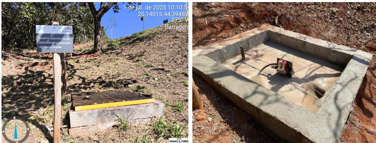
Imagem 10.1 – Caixa de ancoragem da chave de corda nas ombreiras da Barragem Serra Azul.
