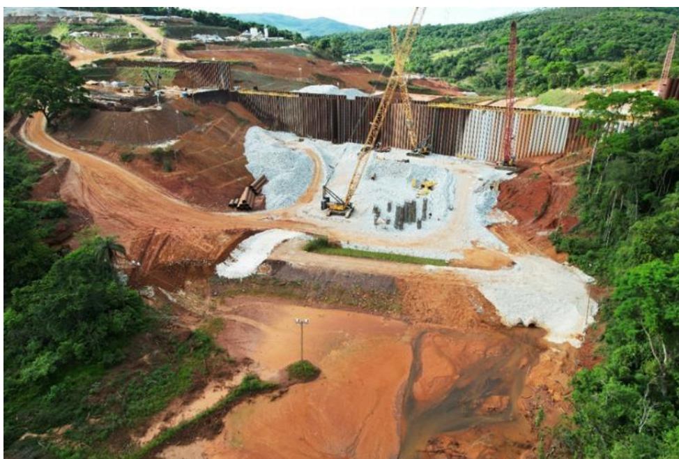
Vista a partir da área a montante da ECJ em novembro de 2024
